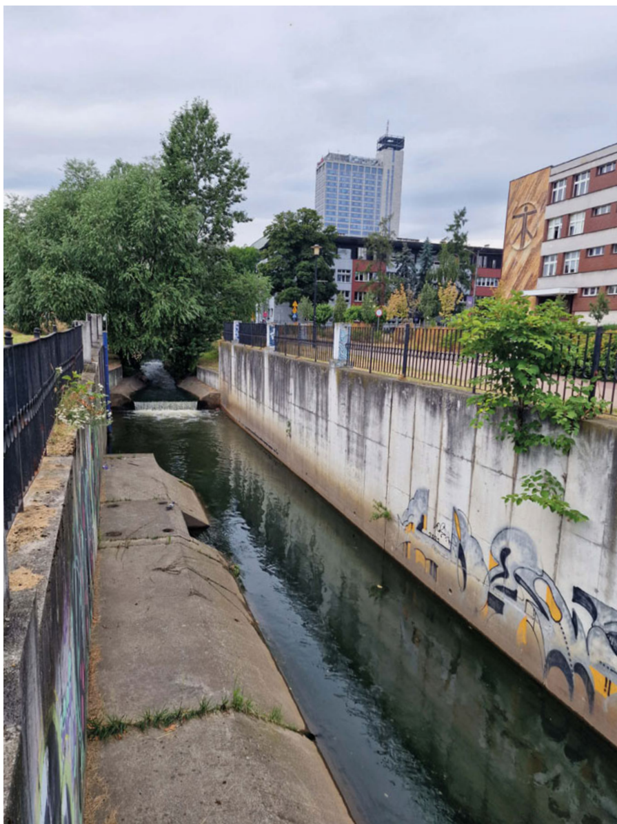
Ryc. 12. Uregulowane betonowe koryto Rawy wzdłuż ulicy prof. Waleriana Pańki w rejonie stacji monitoringowej Uniwersytetu Śląskiego w Katowicach (widoczne fragmenty budynków Wydziału Nauk Społecznych i Rektoratu uś przy ulicy Bankowej; w tle budynek Altus). Fot. D. Absalon.
